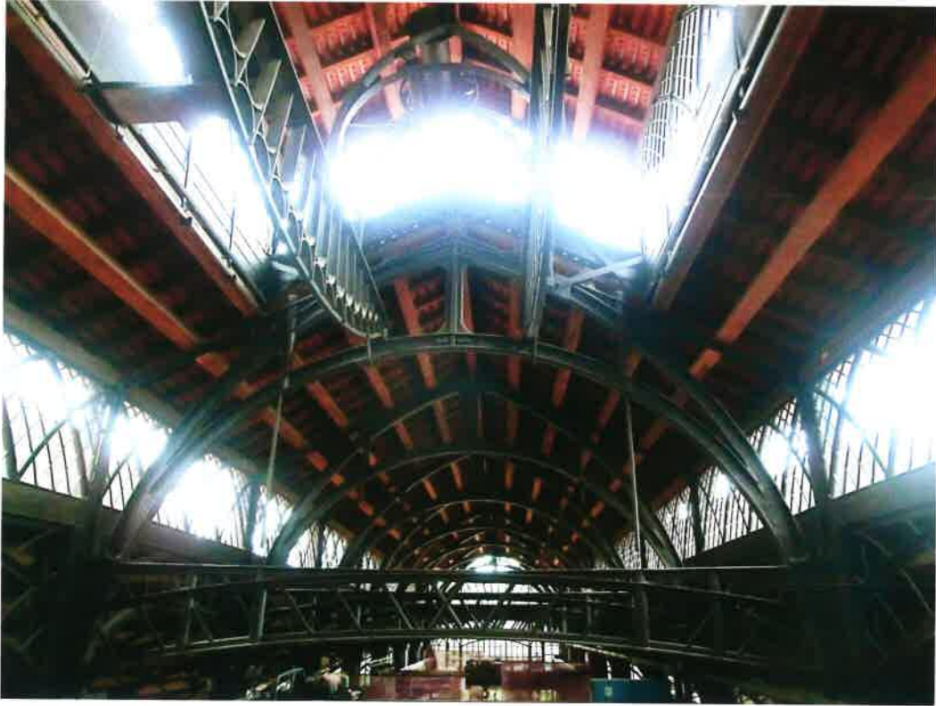
Der Blick vom oberen Hochofenbereich zeigt die gewaltige Hallen- und Dachkonstruktion. Dieser Bereich war zu Betriebszeiten nicht verglast.
