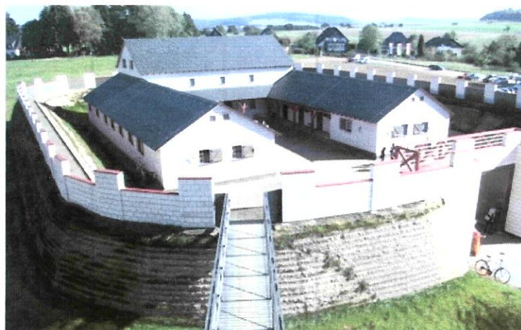
Blick vom Limesturm auf das Kastell
