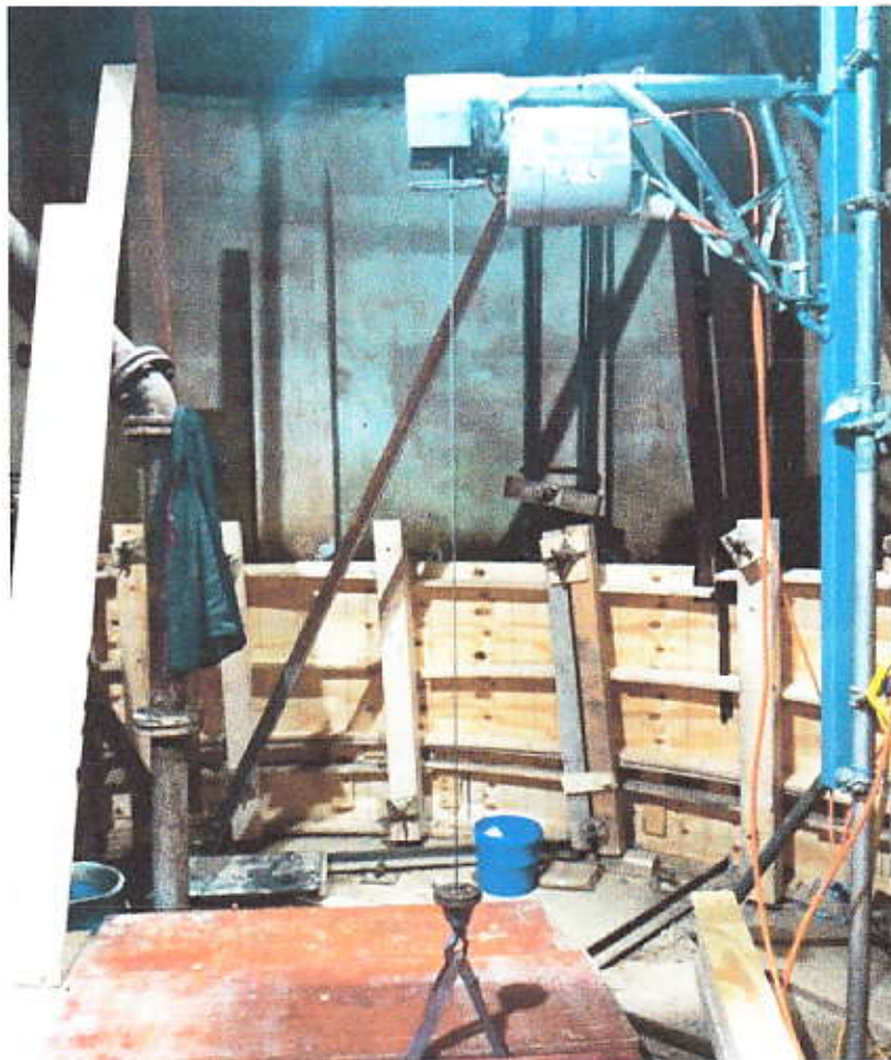
Die Arbeitsebene unter den alten großen Tanks für das Thermalwasser
